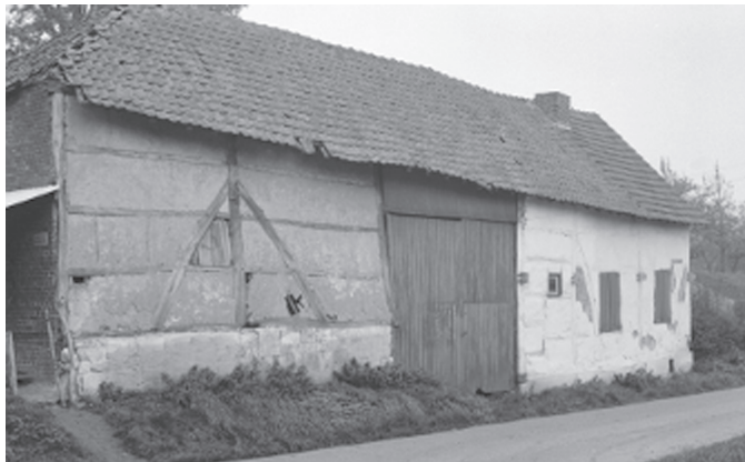
14 Aolbaek, Nieuwenhuisstraat 40, vrm. vakwerkhoeës en sjuur onger ein kap mèt in totaal 7 gebonter. Tösje sjuur en woëngedeelte bevingt zich 'n groeëte poa(r)t. Rechts 't witgekalkde woënhoeës mèt 2 doergebroake vènstere, toegemakt mèt sjeëg. 1962, RDE 82485.
