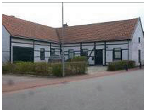
20 Gerieësjbrich (Retersbeek). L-vormig vakwerkhoeës witgeverfd. Later is o.m. de poat verplaatsj. D'r topgeëvel is va mergel, 1992, RDE en 2017
