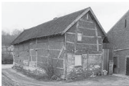
19 Wisjegracht 49, vm. vakwerksjuur. Op d'r ankerbalk sjeit 'n hoeëg jök, aan beids kent vasgemaakt met tweeë blokkele aan de poste. 't Gerieëmsj is gevöld met baksjtein. Onger d'r ankerbalk mergel, 1978, RDE 261387.
