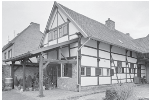
23 Hellebrook 62, rechtsijndig jök op d'r ankerbalk. Teënge d'r topgeëvel sjeit 'nen oapen aanhank, 1991, RDE 190535.
