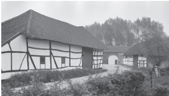
16 Tersjtroate 4, sjiiddaak, vlechtwerk met leëm, witgekalkt, aanhank (of sjop) teënge d'r achterkant, RDE 78363. 16a Tersjtroate 4, Gerestaurierd. Wit-zjwa(r)tbeeld, hoeëgere aaf- aanhank, 1963, RDE 82400.
