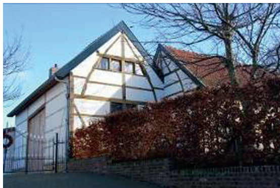
27 Geweustroa (Weustenrade) 't 4-gebontergeboew (vm. sjuur) sjeit hoaks teênge 't woeênhoeës, ongerdeil van 'ne gesjloate, mergele hoof. Jökke met kröppel sjtieële en middesjtieël. De poste zunt gesjoard, 2009.
