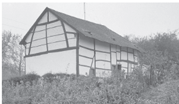
29 Wisjegracht 25, ankerbalk met jök met middesjtieël. Achterdoer klein, vierkante vakke, 1962, RDE 62807.
