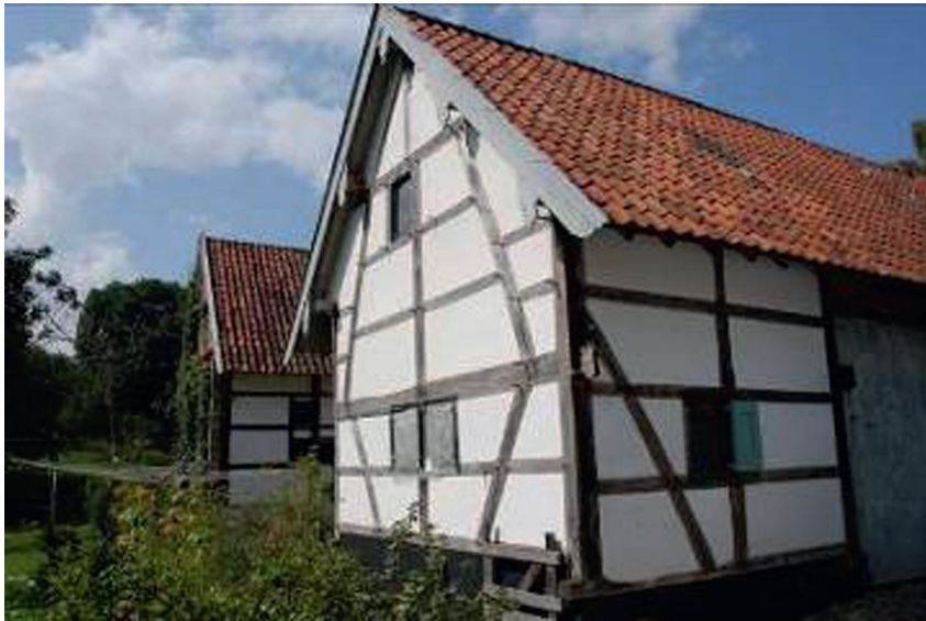
33 Tersjtroate, jök mèt kröppel sjtiele op d'r ankerbalk, 2007
