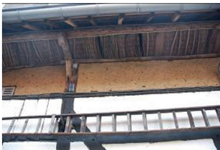
17 Hellebrook, 'Op d'r wörm', onder d'r daakdröp: leëme vakke. D'r waterwörm, woeë-op de keëpesj ligke, sjeunt op oetkraaghaot, 2016.
