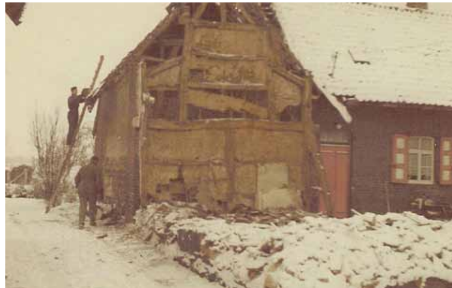
6a De drie vuursjte gebonter van de vrm. sjuur i Zwië zunt hie aafgebroake. Op de foto zieën v'r 't vierde gebont (met rechtsjtoandig jök) leunend op de twieë sjoare van de zieweng links en rechts. Rechts sjteit 't woeënhoeës mèt de vernuide baksjteine sjtroatgeëvel oet 't ing van d'r 19 de ieëw. Foto Meessen, 1963
