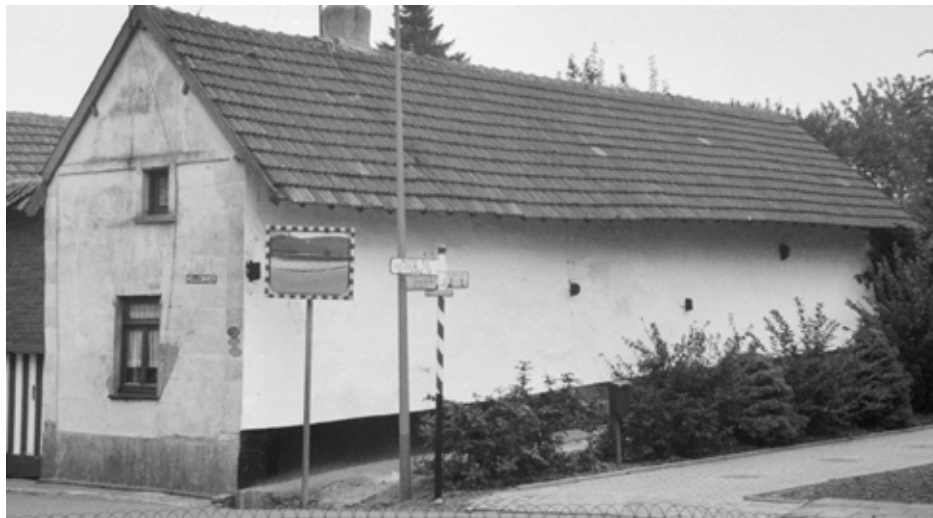
5c Hellebrook, hoeës aan 't Zjwiersj vootpaad, alle vakwerk zit verborge achter kalk en cement. De ange verroaje de plaatsje van de gebonter. Vakwerkhoezer zoage in deën tied oet as witte huuskes mèt 'willekeurig' geplaatsjde klein vënsterkes. 1977, RDE 190535
