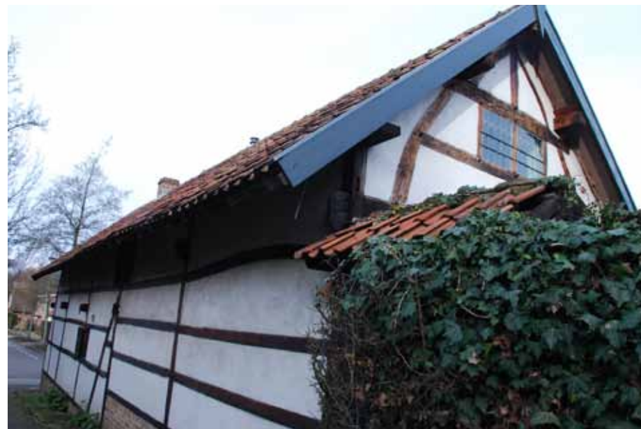
5a Hellebrook, op 't ing van 't Zwiërs voetpaad, oprèksjke van 4+2 gebonter, 5 travéeë, lankgerekde vakke en lang sjoare. Gerestaureerd in 1993. Foto 2016.
