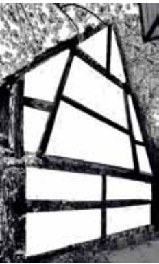
10a 'n Tösjegebont van ditzelfde optröksjke hat kröppel sjtiele op d'r ankerbalk sjtoa. 1999, RDE 330915. 10b Oprichtdatum den 23 may 1644 in 'ne reëgel.
