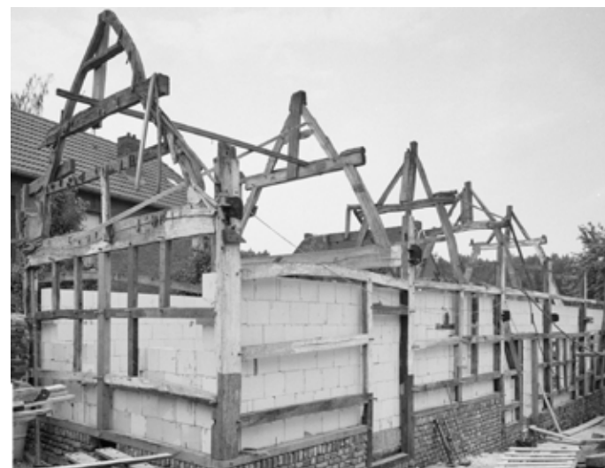
5b Hellebrook: de gebonter bie de restauratie in 1993, gezieë vanaaf d'r binneplei. 'n Riej wirvels liekene op 'ne wervelkolom. Aoch de kuueningskes zunt good woar te numme. RDE 300968
