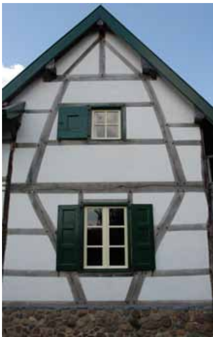
7 G'ne Brand, eenvoudig gebont met op d'r ankerbalk 'n jök mèt kröppel sjtiele. Onger d'r ankerbalk sjtoan twieë sjtieëpe. Alle balkwerk lieët hie, met get fantasie, de vorm van 'n 'baar' zieë. De venstere kenne gesjloate weëre mèt sjeëg. 2014.
