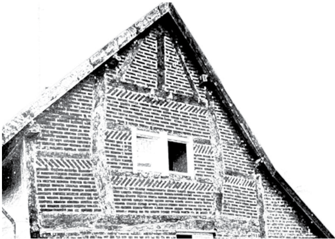
10 Vrm. topgeëvel i Zjwier, nommer 17, (noe 53), op d'r forsje ankerbalk sjeit 'n H-frame-jök (de jöksjtiele laope doer, langs 'ne tösjebalk-ligker), met blokkele vastgemaakt aan post en daaksjpant. Op d'r wirvel sjeit 't gesjoard kuueningske. 't Daak hat rechts 'nen aafhank (doersjleipend daak), 'n oetbreiing richting d'r achtergaard. Bie 't later völle van de vakke mèt bakstjein koam me neet gans precies oet, de boavenste loag woert doarom aagepast mèt 'n sjtruimloag (sjuins gemetselde sjein). Foto Ger Hukkelhoven, 1960
