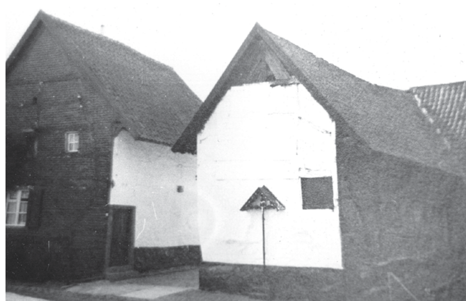
2 Vuormalige vakwerkhoeëzer in 't centrum va Zjwier in 1955. In d'r topgeëvel van 't hoeës (19de ieëw) links is 't gerieëmsj gevöld mèt baksjtein. Op d'r ankerbalk sjteit 'n jök mèt middesjtjel, zuug foto 2a. De duur zit in d'r ziewand aan 't getske, hangend aan 'ne post. Aan d'r angere kant van 't getske sjteit de vrm. 18de ieëwse, witgekalkde sjuur mèt kruutske. D'r zichtbare ziegeëvel is nog va onbedekte leem. D'r sjprunk löpt onger 't uueversjteëkend daak doer, langs de mèskoel. De wuuning, woeëvan rechts nog 'n sjtökske te zieë is, hat 'ne vernuide sjteine sjtroatgeëvel oet 't ing van d'r 19de ieëw.
